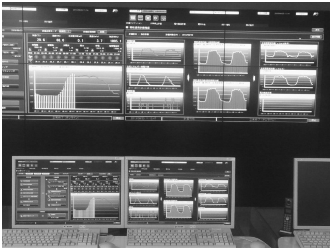
図3 北九州スマートコミュニティ創造事業の中核となる地域節電所の内部（筆者撮影）
