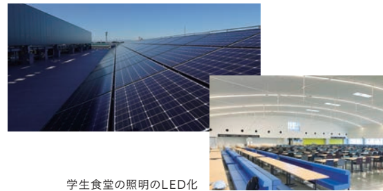
学生食堂の照明のLED化
