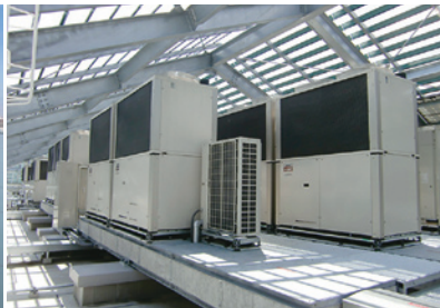
高効率発電型ガスヒートポンプ (GHP)
