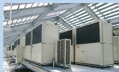
高効率発電型 GHP (ガスヒートポンプ)
