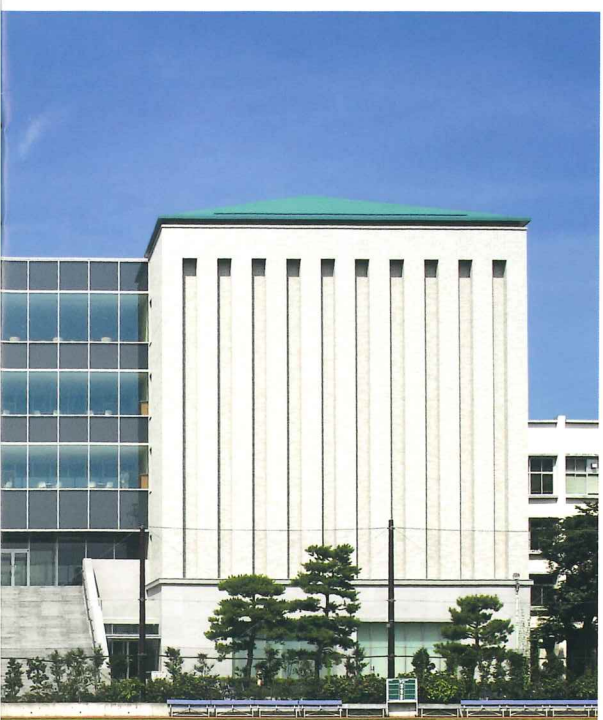
セミダブルスキンによる高遮熱構造 中庭屋上庭園による緑化と屋根断熱
