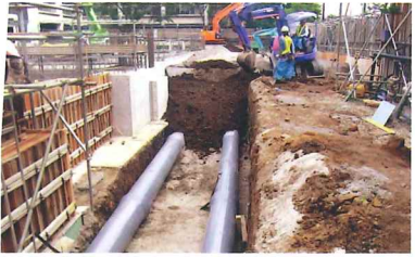
施工中のクール/ヒートチューブ
