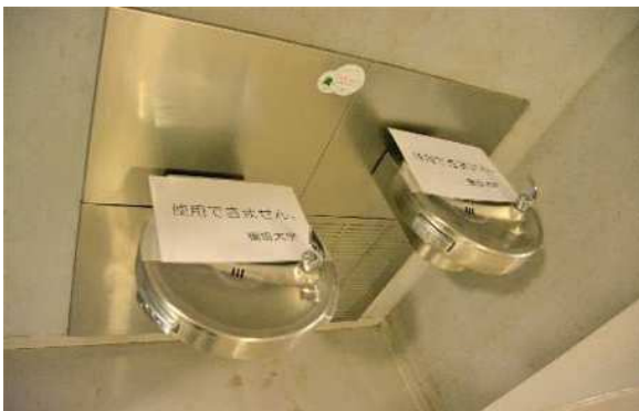
給水機は使用不可
